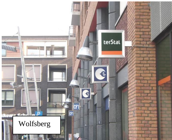
Uitvoering gevelbord haaks op de gevel.
